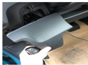
3.6 接正极线：需拆下主驾驶室内盖板，正极线束连接于此处位置；
